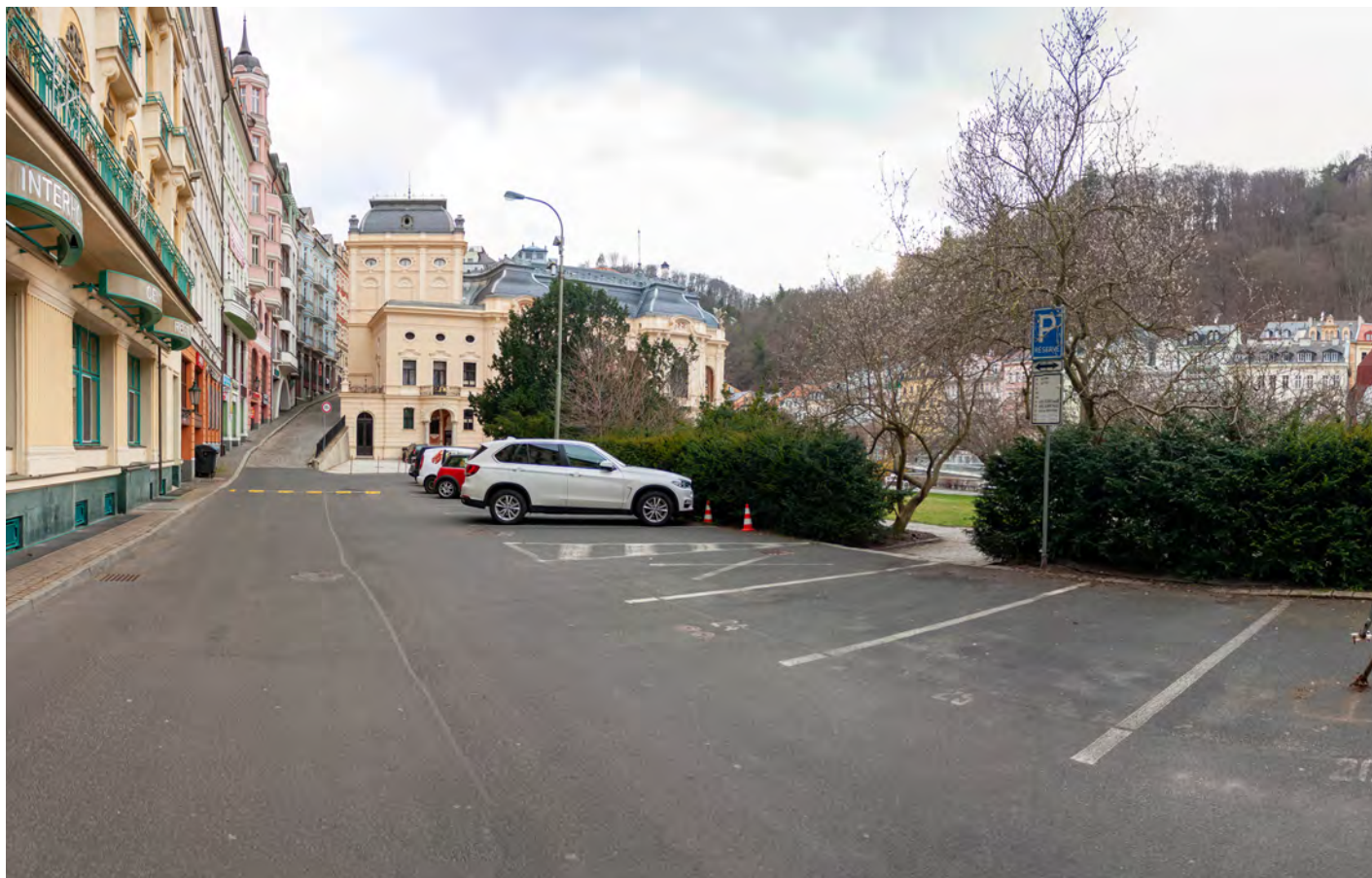
5/ Přerušené vizuální, prostorové i pěší vazby po celém obvodu. Parter budov je zcela odříznut od náměstí.
