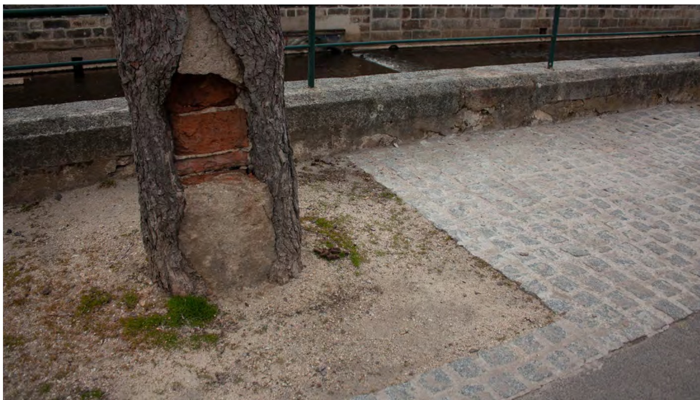
11/ Stromořadí jírovců u řeky v havarijním stavu.
