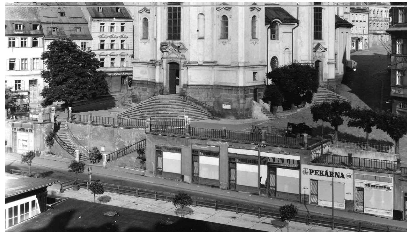
2/ 1965 - tržní krámky u opěrné zdi z 20. let 20. století krátce před demolicí
