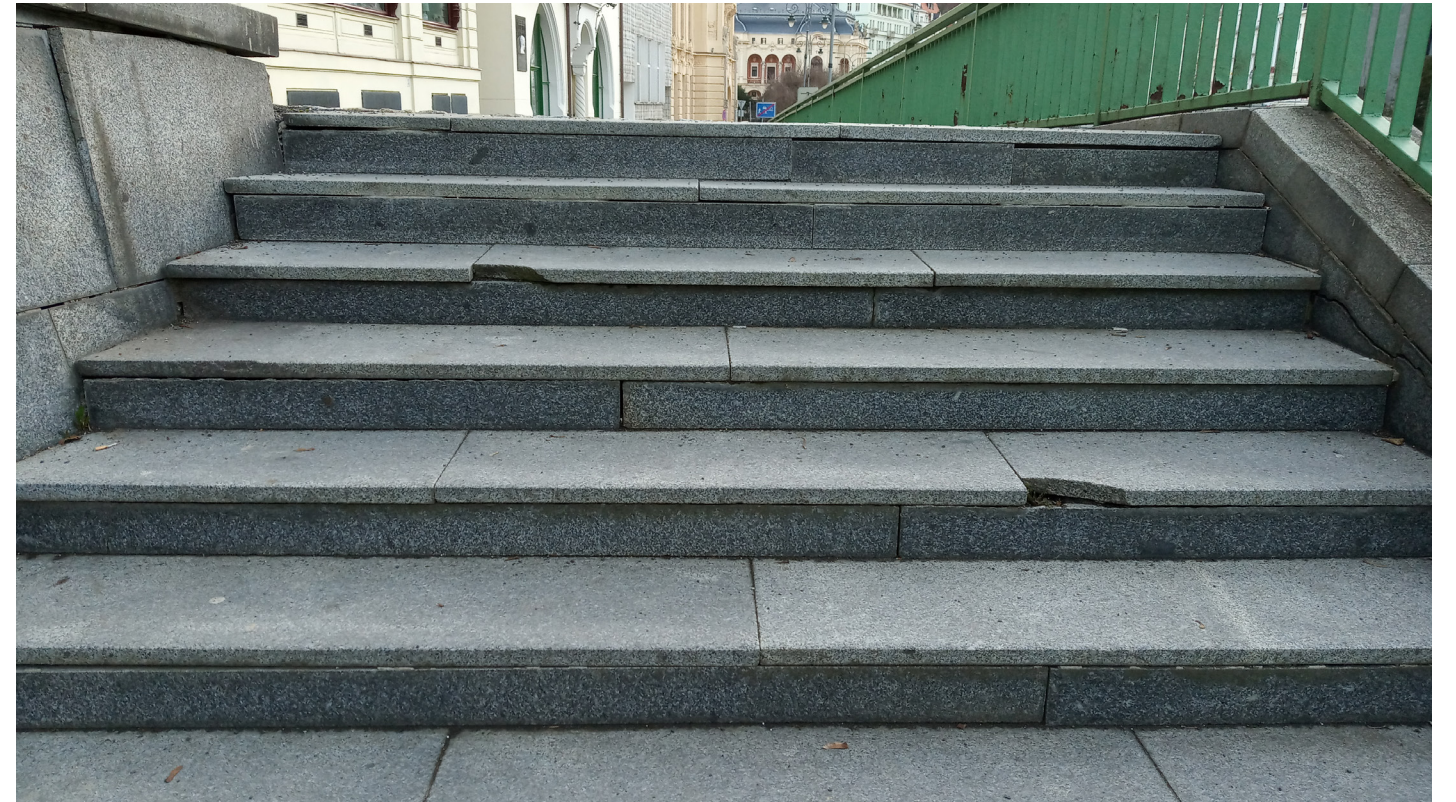
9/ Schody tvořené tenkými žulovými deskami - nevhodné řešení v historickém kontextu
