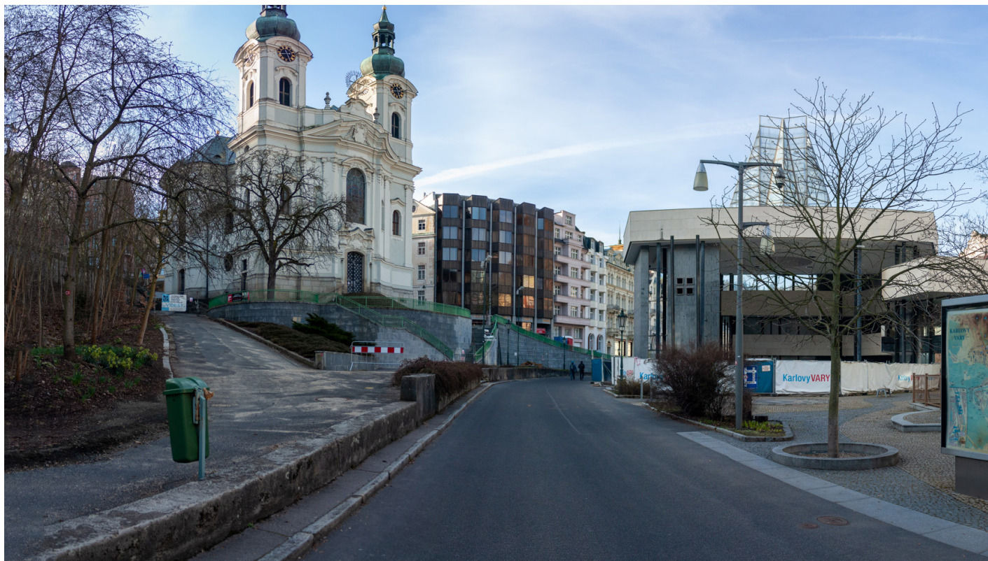
1/ Zbytečné bariéry tvořené opěrnými zídkami, stav neodpovídá dopravnímu režimu pěší zóny
