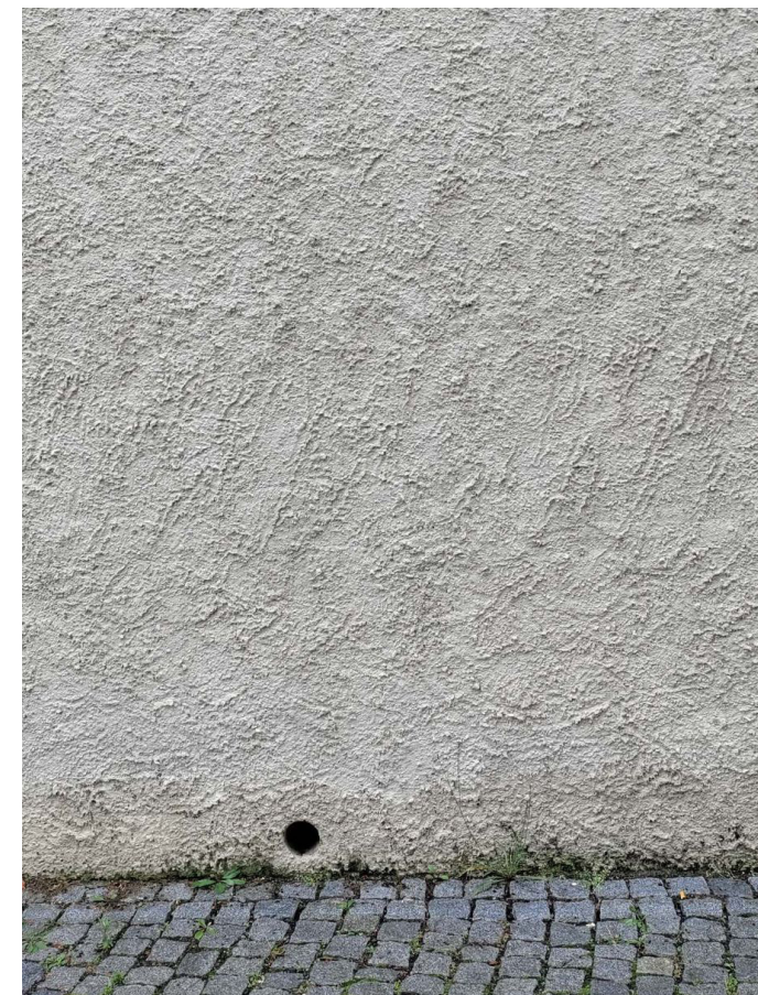
Reference hrubě omítané zdi (Zámecké náměstí, Teplice)
