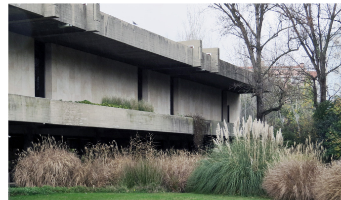
Reference usazení budovy do vegetace (Gulbenkian Museum, Porto)
